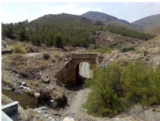
Estado actual del puente sobre el barranquillo de La Almagrara en la antigua carretera de Vilches (Foto del autor, junio 2016)
